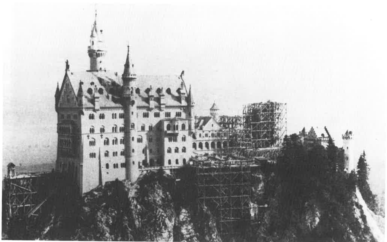
Kurz vor der Fertigstellung
