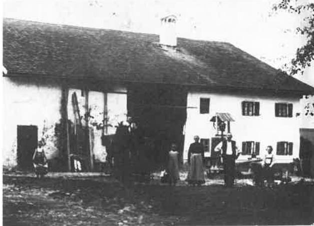
Altes Bauernhaus mit „Göppel“ in Riesen bei Steingaden
